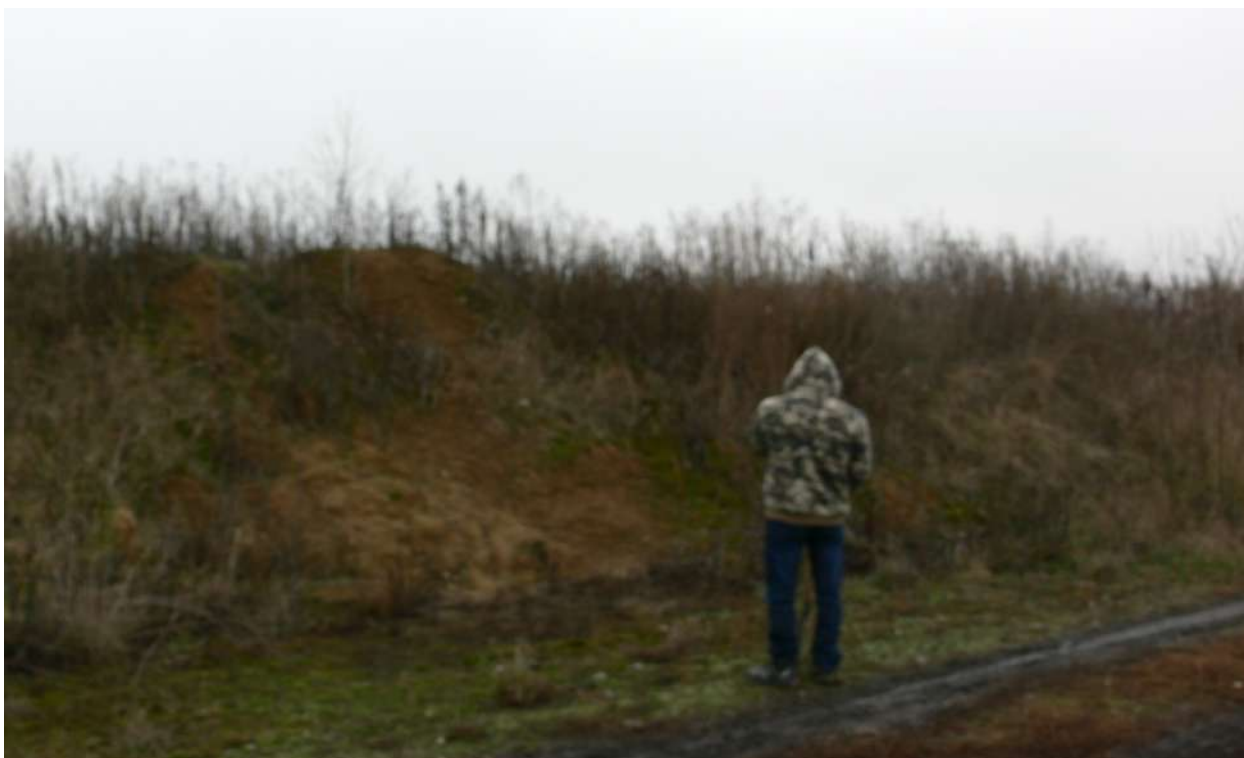
Рис. 5. Обваловка прудов-отстойников на участке
