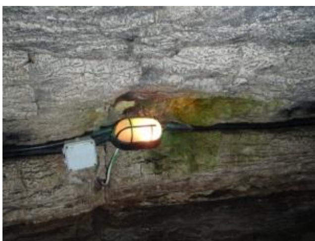
Рисунок 4.16 – Лампа освещает небольшой участок на своде
