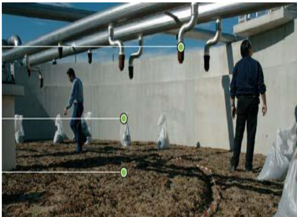
Рис. 12 – Вид изнутри установки по вермифильтрации для очистки муниципальных сточных вод.
