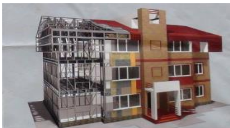
Рисунок 1.9. Малоэтажный дом на основе металлоконструкций в г.Владимире
