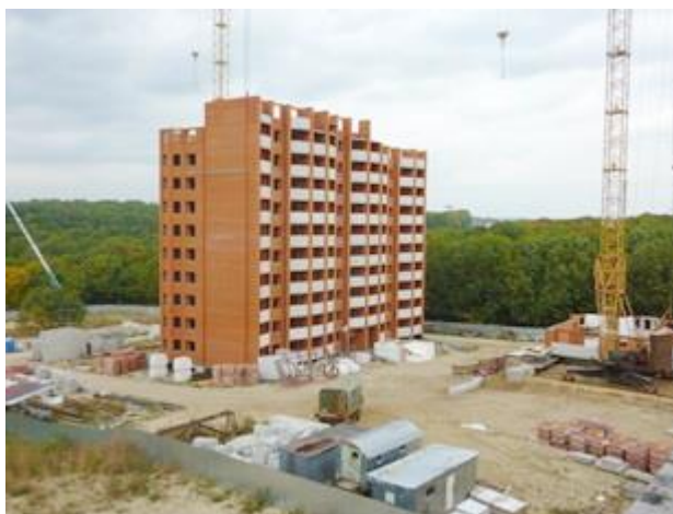
Рисунок 4.2. Строящееся здание во Владимире
